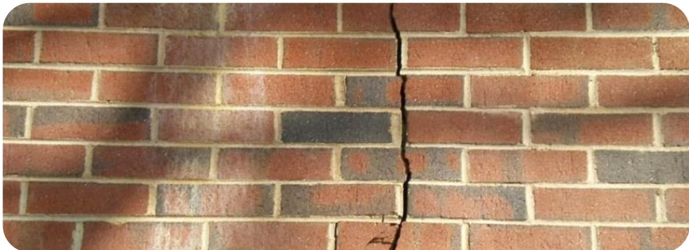
Причины трещин — некачественно залит фундамент, не соблюдены нормы при кладке, не заложено армирование стен.
